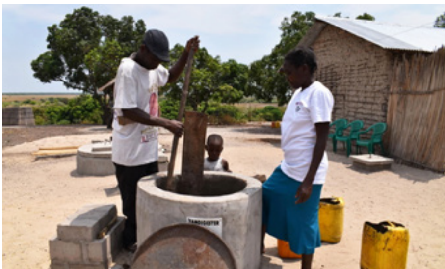
» Člověk v tísní pomáhá v Zambii stavět jednoduché bioplynové stanice pro domácnosti. FOTO: ČLOVĚK V TÍSNÍ
