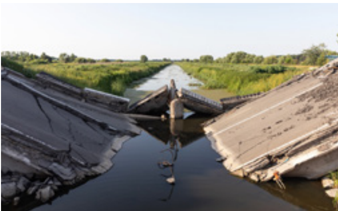
» Rekonstrukce Ukrajiny již začala. Mimo jiné je nutné v řadě míst urychleně obnovit dopravní infrastrukturu. FOTO: SHUTTERSTOCK
