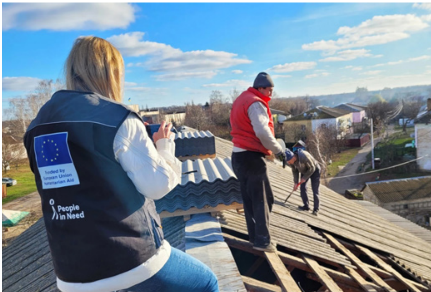
» S podporou EU rozjel Člověk v tísní na Ukrajině projekt menších oprav domů a bytů.
