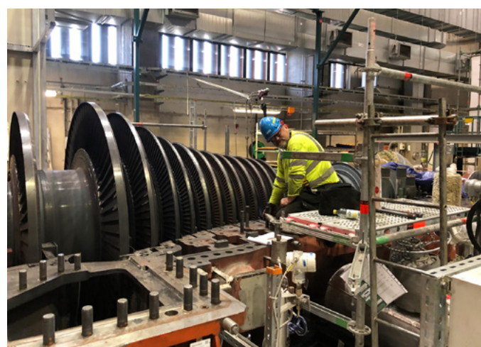
» Inspekce turbíny Doosan Škoda Power na elektrárně Stockholm Exergi (Värtan). FOTO: MARTIN BAŠTA
