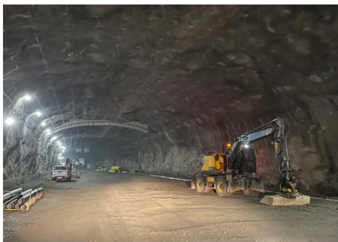
» Stavební práce firmy Subterra ve Stockholmu. FOTO: SUBTERRA
