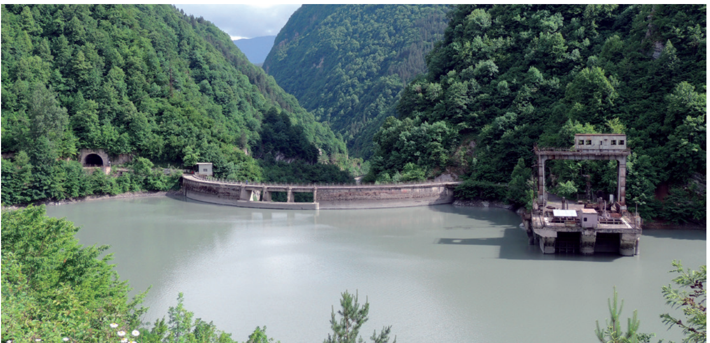
» Elektrárna Ladjanuri se nachází na vodním toku, který vznikl přesměrováním řeky Tskhenistskali do řeky Ladjanuri. Jde o podzemní elektrárnu s instalovaným výkonem více než 110 MW. Zahájila provoz v roce 1960, součástí skupiny ENERGO-PRO je od roku 2007. Foto: ENERGO-PRO
